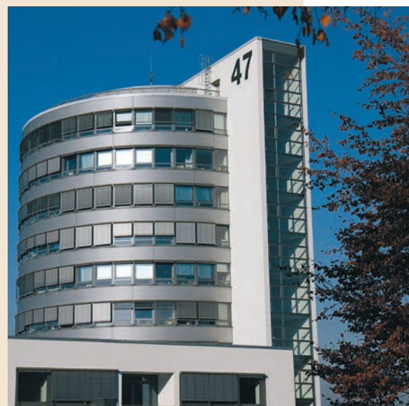
Von links: Gebäude 47 in Kaiserslautern,
