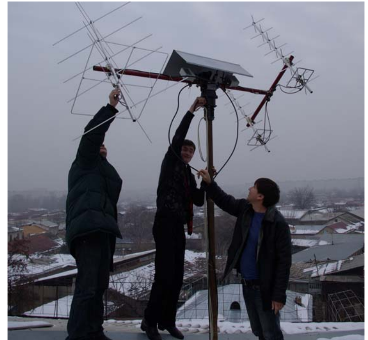
Aufbau einer UHF/VHF Satelliten-Bodenstation
